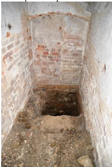
Sonda pod stávajícím schodištěm.
